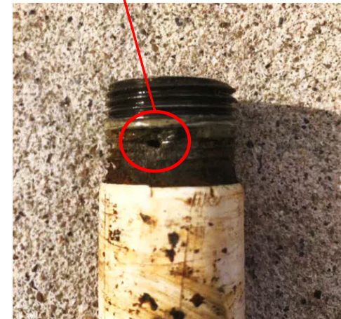
腐食によりあいた孔
