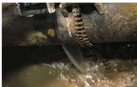
切断中のガス管から流れ出る水
