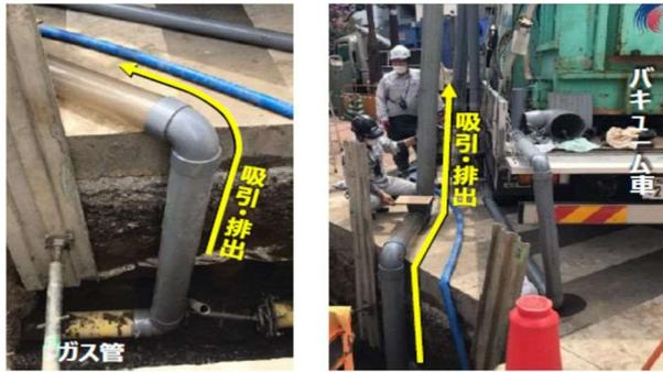
ガス管内の水・土砂の吸引作業例
