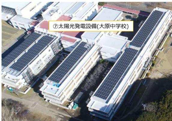
合計**528枚**の太陽電池モジュールを設置
