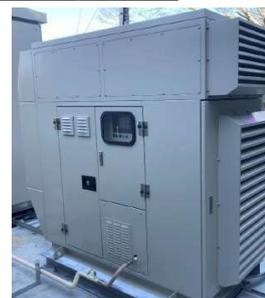
③50kVA LPガス発電機用インバータ (電圧源/電流源)
