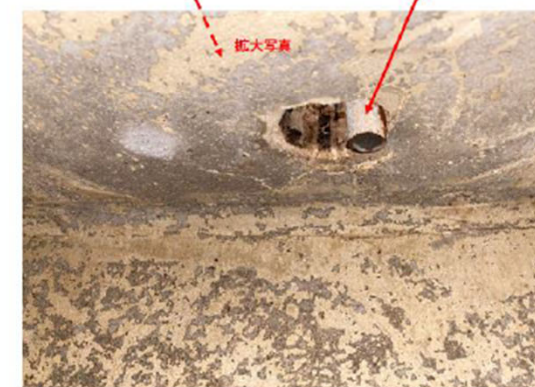
床下ピット内
