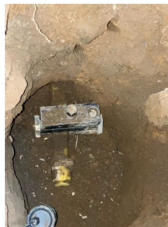
地境切断掘削口 地境切断箇所
