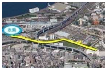
街中の水素パイプライン 北九州市水素タウン実証・PR事業
