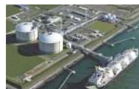
ひびきLNG基地 2023年 メタネーション実証事業開始
