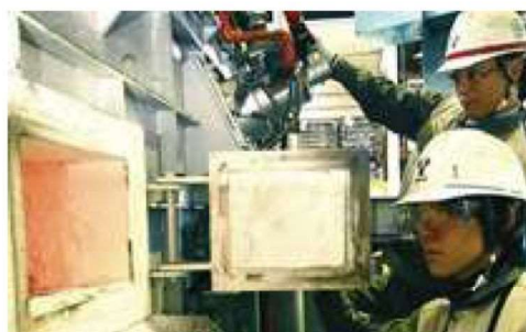
お客さま設備の改造・調整作業
